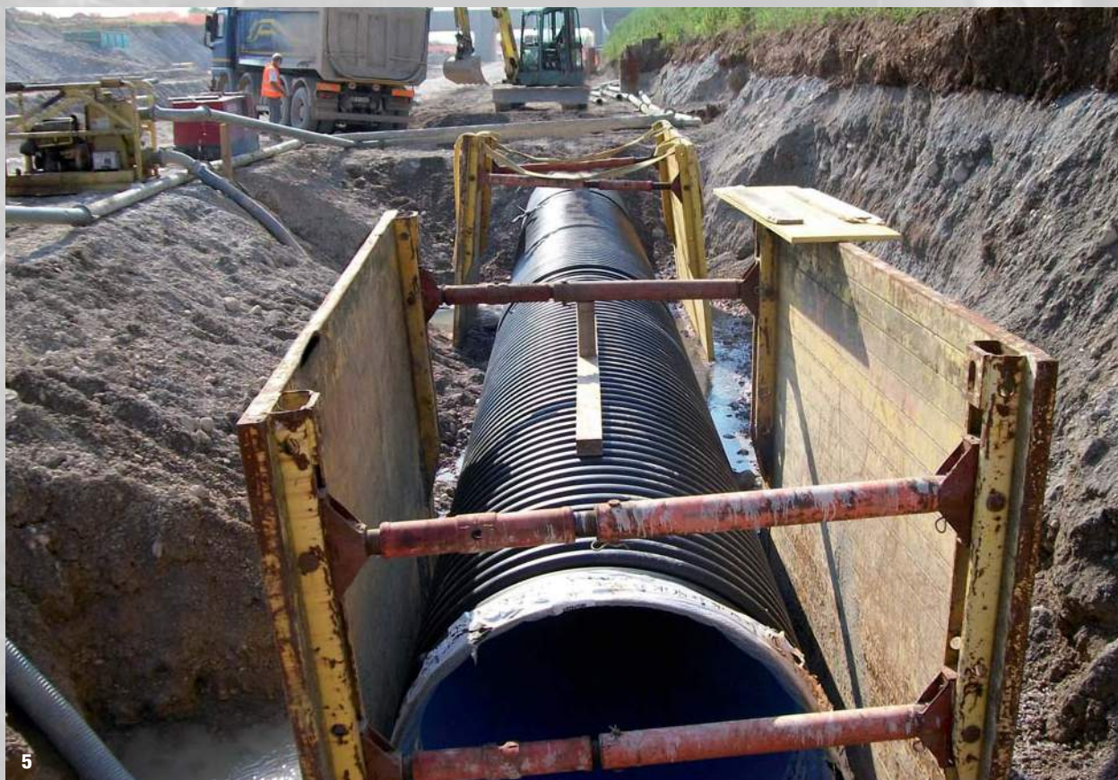
5, 6. Fasi di elettrosaldatura
