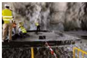
verifica generale e smontaggio griglia di ghisa
