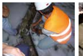
verifica generale e smontaggio griglia di ghisa
