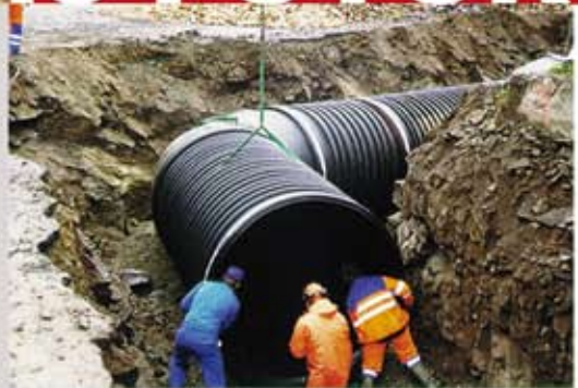
Tuyauteries Spirales de grands diamètres en PE et PP
