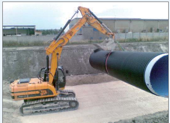
Figura 8 - Un esempio di movimentazione in cantiere
