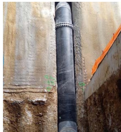
Siphon Ø1200 - Milano (MI)
