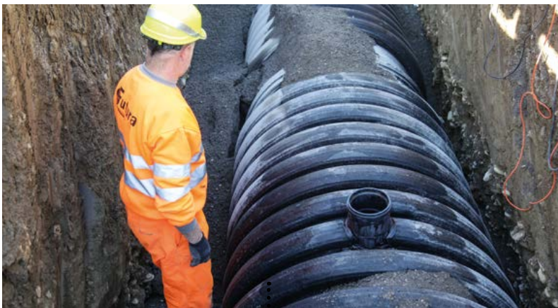
Welding intervention 1200 - Belforte all'Isauro (PU)
