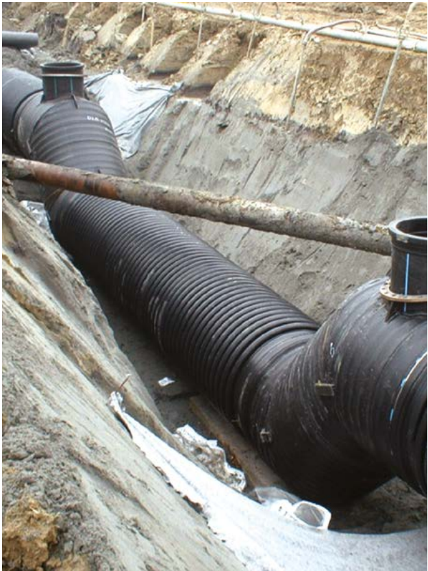
Siphon SGK Ø1200 PN1 SN4 HDPE Ravenna (RA)
