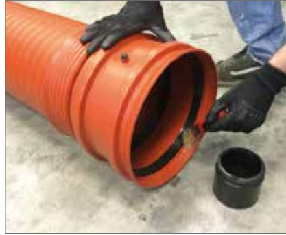
pulizia e lubrificazione delle guarnizioni
