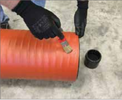
- pulizia e lubrificazione delle superfici di infilaggio
